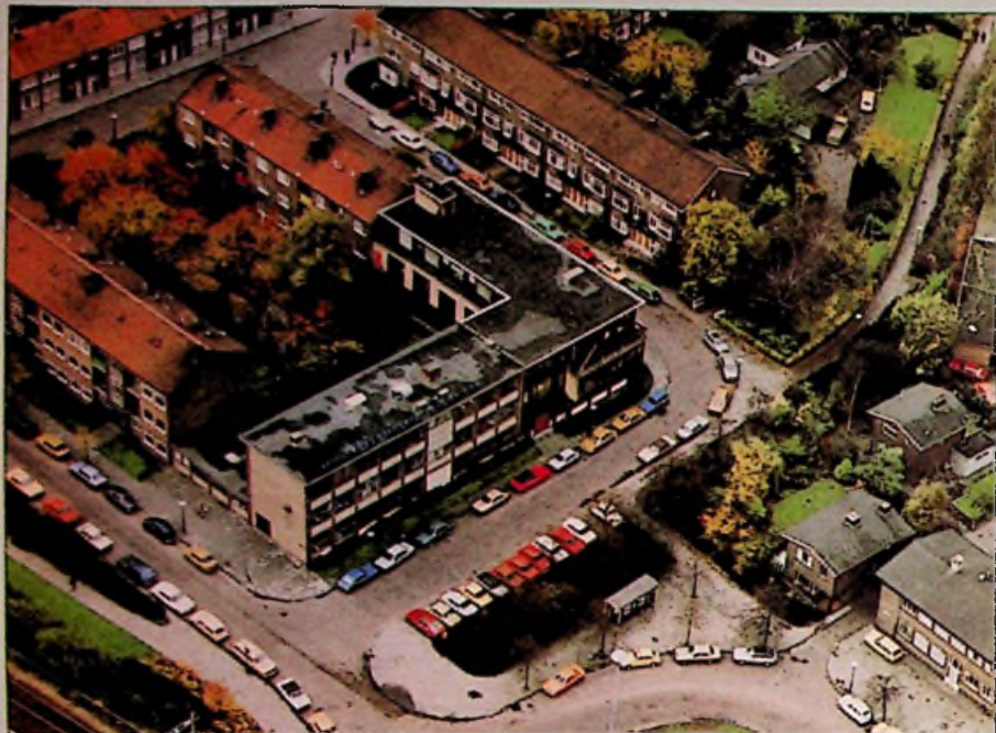
Luchtfoto pand Betronic, ter Gouwstraat
