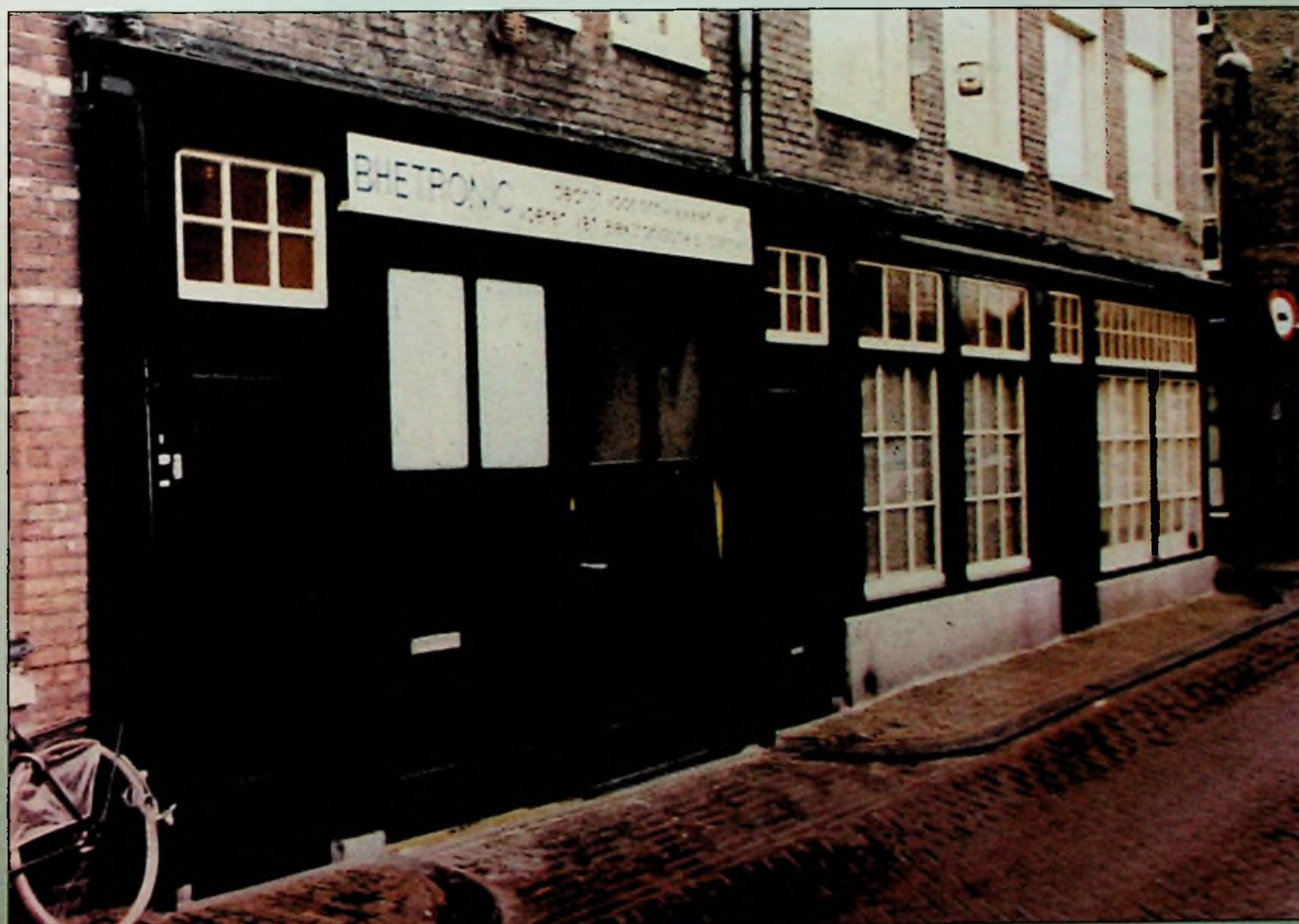
Garagepand aan de Egelantiersgracht 191
